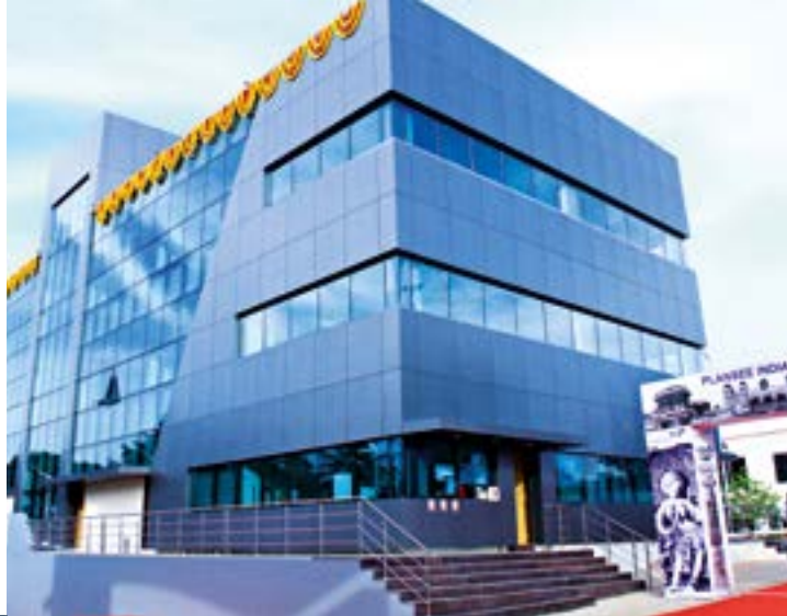
Teil des Plansee Produktionsverbunds: Das neue Produktions- gebäude von Plansee Hochleistungswerkstof- fe in Mysore.
